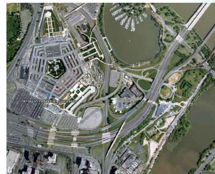
Рис. 4. Пентагон, Министерство обороны США (синхронное нанесение разметки, заметен низкий уровень светлоты и контрастности на ездовом полотне мостовых сооружений)
