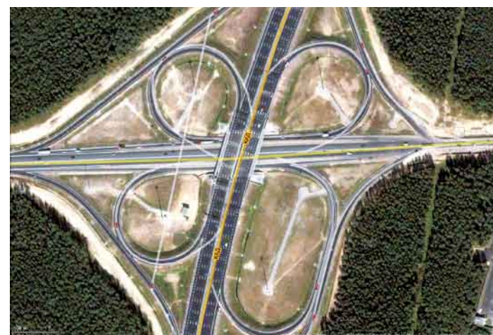
Рис. 5. Кольцевая автомобильная дорога, г. Санкт-Петербург (высокая светлота и контрастность, хорошая синхронность)
